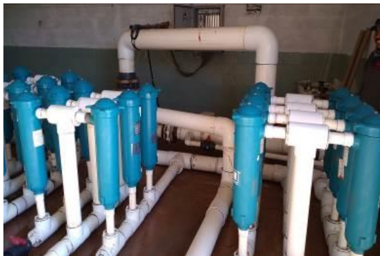
Figura 11. Sistema de filtrado con cartuchos de 5, 15 y 25 \mu .
